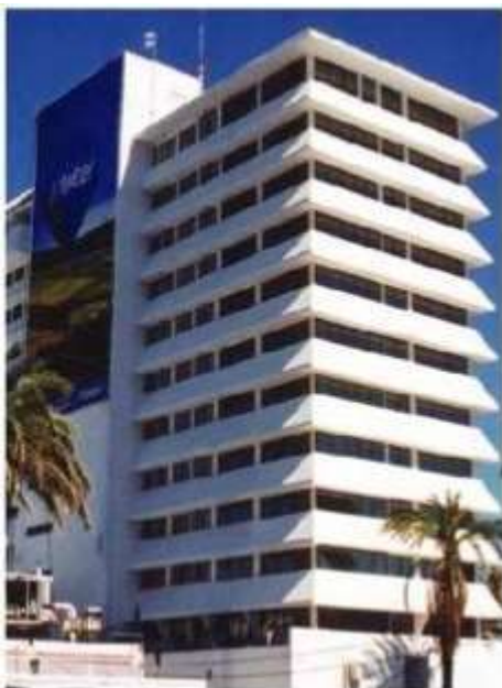
Edificio Corporativo Telcel Hermosillo
